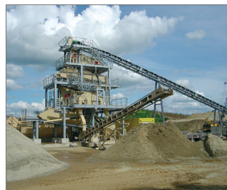
Рис.3 Установка с лопастной мойкой и просеиванием материала
