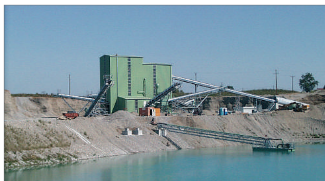
Рис.2 Промывочная установка, закрытый способ переработки
