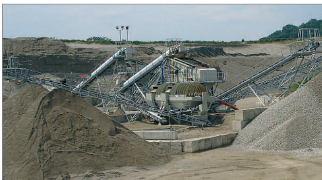
Рис.1 Промывочная установка, открытый способ переработки
