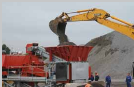
Дробильная установка SMR 10/05/4 в работе на строительстве ВПП
