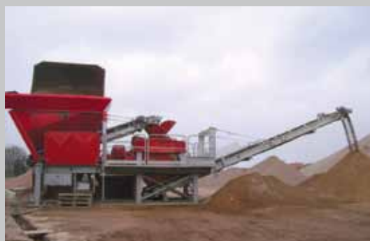
Дробильная установка V 08 в работе на песчаном карьере
