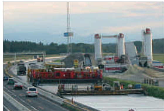
Рис. 1 Строительство бетонного автобана при помощи бетоносмесительной установки EUROMIX
